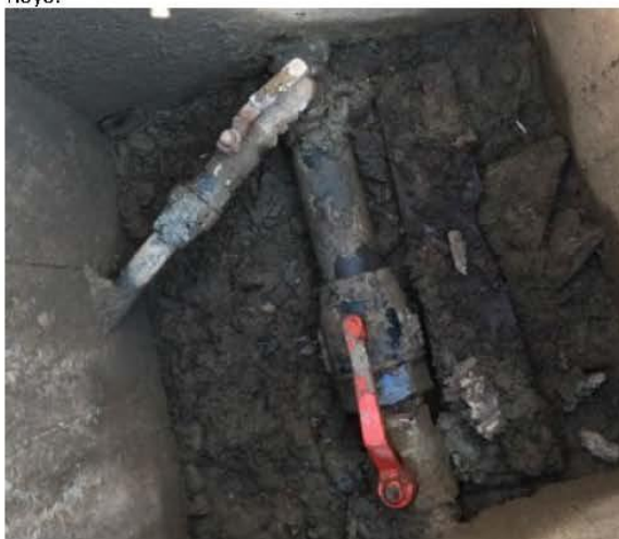
Arqueta B (Esto encontramos en la arqueta junto a la fuente que va en paralelo a la BI-2701 y que surte a la fuente).
