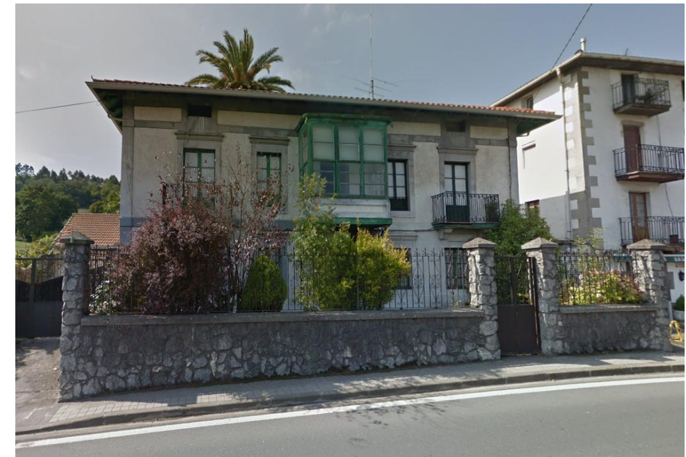
Edificio en la margen derecha de la carretera BI-2701, a la altura del P.K. 27+840.
