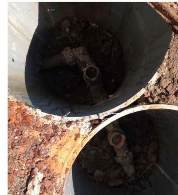
Arqueta C (Esto se ve en la arqueta junto al acceso del bar en la BI-2701, donde se ve claramente que abastece la vivienda y continúa en dirección Balmaseda). De modo que, no entendemos cómo conecta esta tubería con la tubería de la arqueta B. En este punto creemos que hay una parte de la red que no conocemos o que son dos redes.
